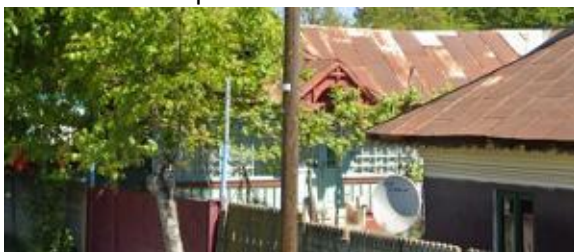
46 Strada Florilor nr. 7
